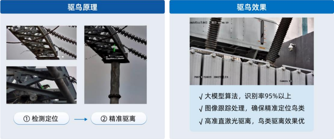
图 4-9 精准识别、激光驱鸟，保障电网运行和鸟类安全
